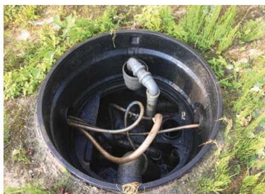
7. Widok na elementy bioreaktora jednej z badanych oczyszczalni SBR po kilku latach eksploatacji
